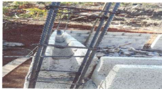
Foto 4: Se hizo reparación de paredes.
