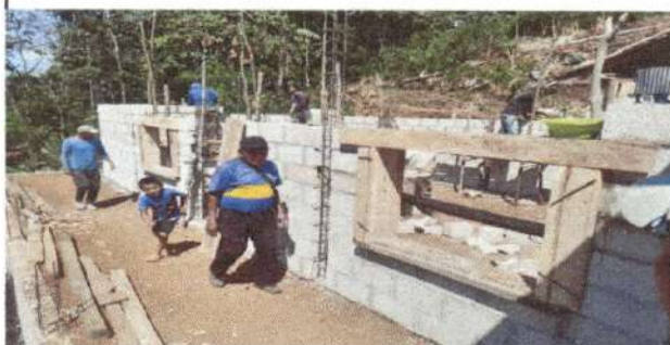
Foto 6: Se cambió la estructura de las ventanas
